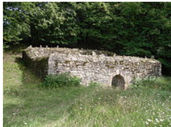
Ruine eines mittelalterlichen Burggebäudes auf dem Glauberg
